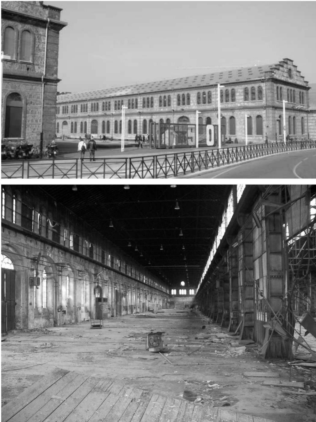
Figure 4. Torino, the sheds of Officine Grandi Riparazioni Ferroviarie.
